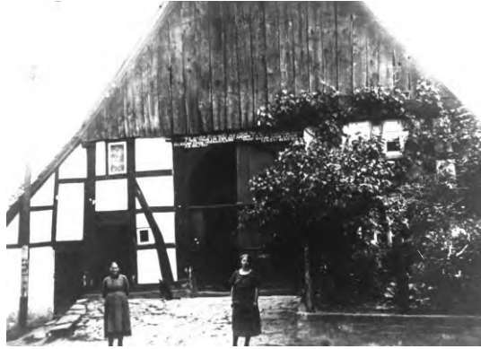
Abb. 1: Hof Meinberg Nr. 47 Tweesmann; Das 1738 erbaute Haus Tweesmann in der Brunnenstraße
